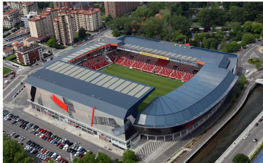
Remodelación del Estadio El Molinón – Gijón – 2012.
