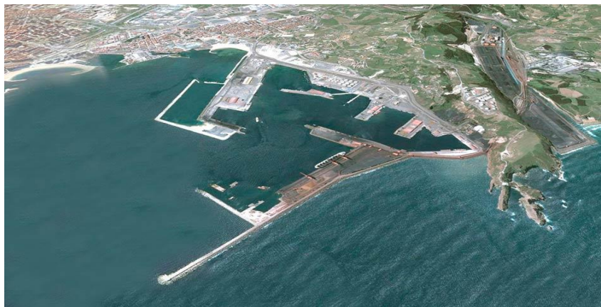
Ampliación del Puerto El Musel – Gijón – 2011.
